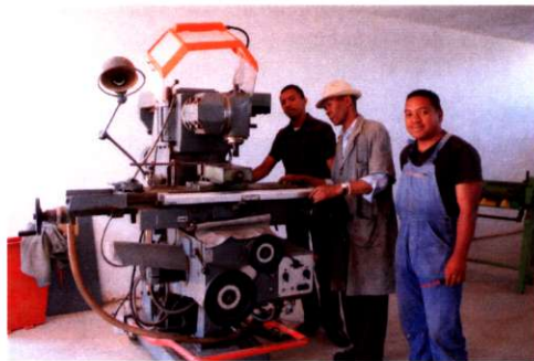
Photo 3 : Les premiers augets, fabriqués avec une école techniques de Tana, ont été montés à l'atelier Tsiky à Tana : le premier générateur de type pelton sera installé courant 2013
