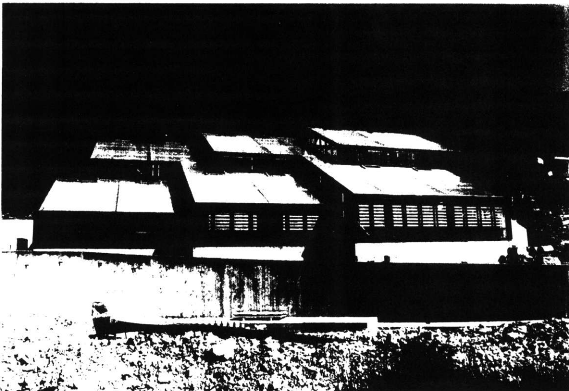
Vue frontale des nouvelles serres. Remarquez le toit en "Hostaflon".
